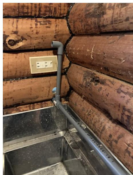
給水PV管もつないで、排水トラップを収めて、排水管も二股の部品をつないで排水できるようになりました。排水トラップのの大きさが少し違うので、水漏れがありました。これについてはパッキンやコーティング剤で固定しようと考えています。また、排水トラップを固定する治具があるので次回はそれで、もう少しネジを閉めることにしました。
